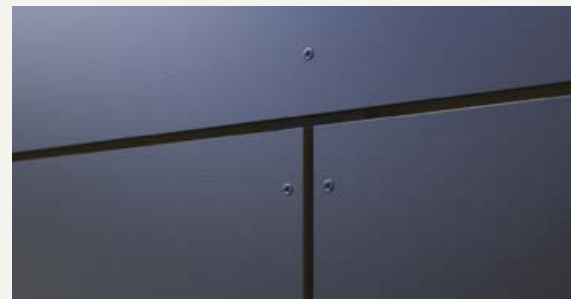
2. HPL- en vezelcementplaten: Voegen moeten minstens 10 mm breed zijn.
